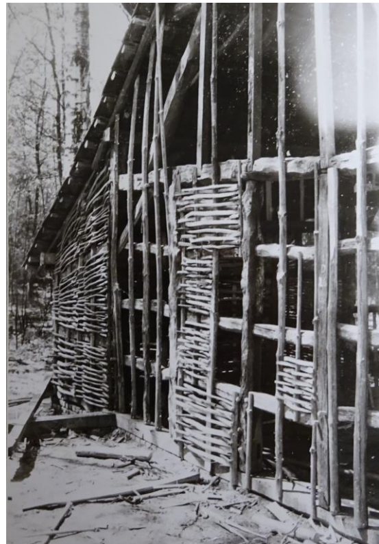
Vitselwerk zuidelijke sluitgevel van het bakhuis uit Heist-Goor tijdens de opbouw ervan in Bokrijk in 1964 (Fototheek Bokrijk, F 187/71).
