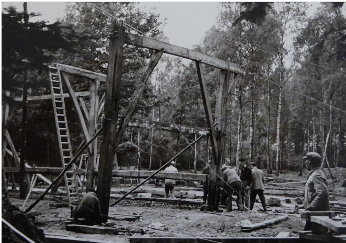
Het optrekken van het laatste gebint van de Uitschoolhoeve uit Oevel te Bokrijk in 1954. (Fototheek Bokrijk, F.6.32.).
