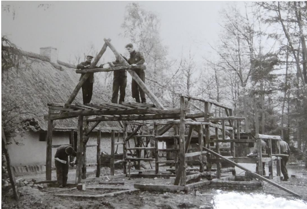
Het richten van de eerste dakspant van een bakhuis tijdens de heropbouw ervan in Bokrijk in 1964. (Fototheek Bokrijk, F.186/61)
